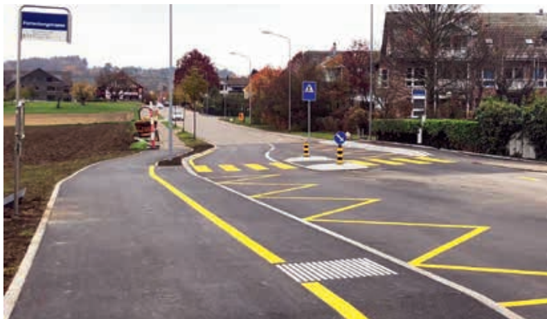
Bushaltestelle Forrenberg: benutzerfreundlich erhöhte Zustiegskanten, kombiniert mit einer zeitgemässen Fussgängerquerung.
